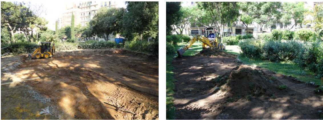
Vista dels treballs de rebaix de terres pel desplaçament de la zona del pipican.
