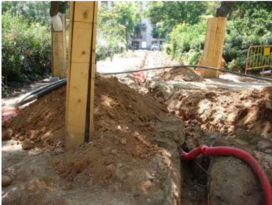
Vista des del nord-est de la rasa 100.
