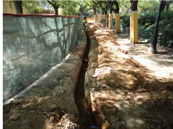
Vista des del nord-est de la rasa 200.
